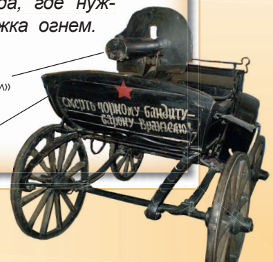
телега на рессорах – упругих подвесках, уменьшающих тряску
