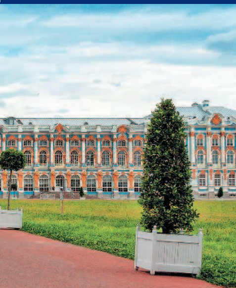
Северный фасад Большого Гатчинского дворца.
