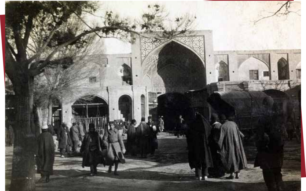
Базарный комплекс в Тегеране
