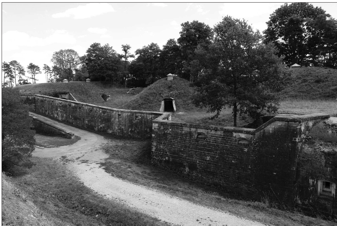
Илл. 15. Южная батарея форта Вилле-ле-Сек (Villedu Sec), вид с горжевой стороны. Батарея почти не подверглась модернизации и состоит из открытых позиций для артиллерии, разделённых траверсами, в которых устроены убежища. Фотография автора, 2015 г.
