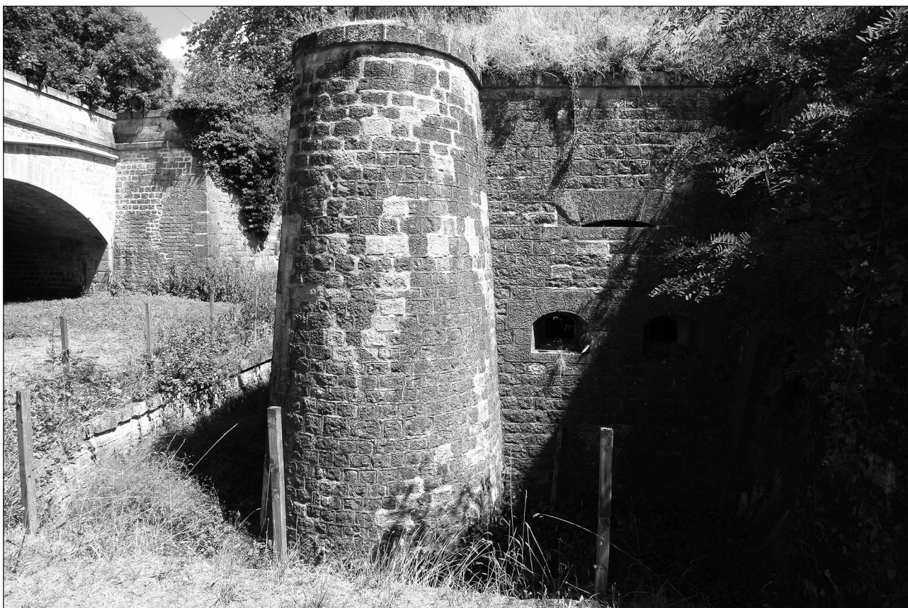
Илл. 14. Капонир Южной батареи форта Вилле-ле-Сек (Villey-le-Sec). В центре фотографии виден округлый выступ-орильон, прикрывавший фланк капонира от огня противника. Фотография автора, 2015 г.
