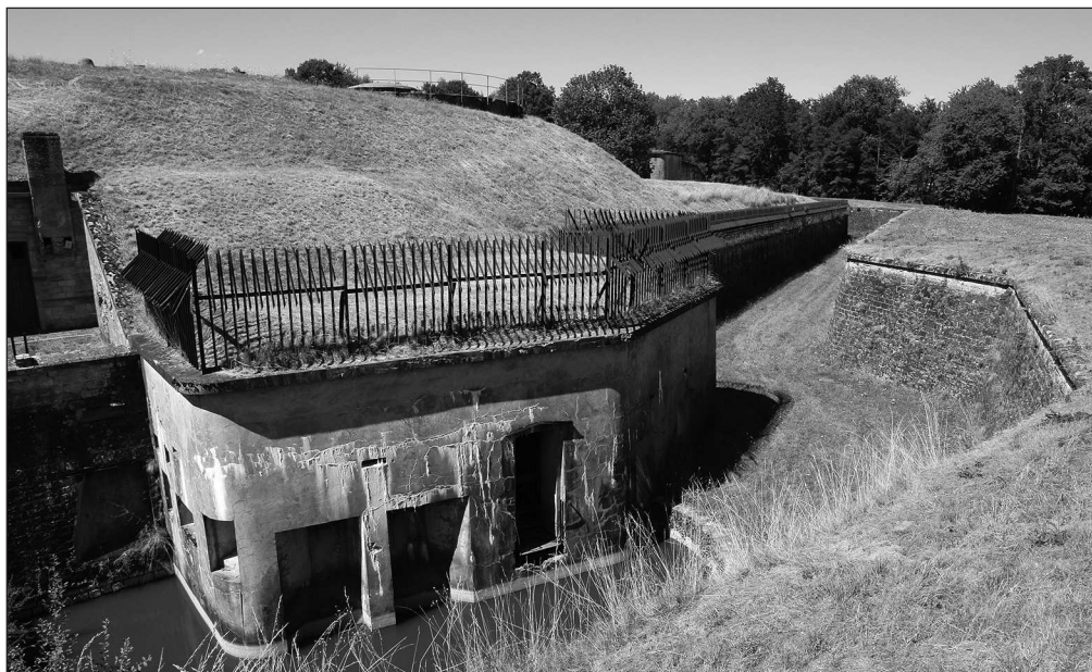
На с. 17: илл. 10. Навесная бойница типа арочного машикуля (франц. créneaux de rideau ) у капонира Южной батареи форта Вилле-ле-Сек (Villey-le-Sec). Фотография автора, 2015 г.
