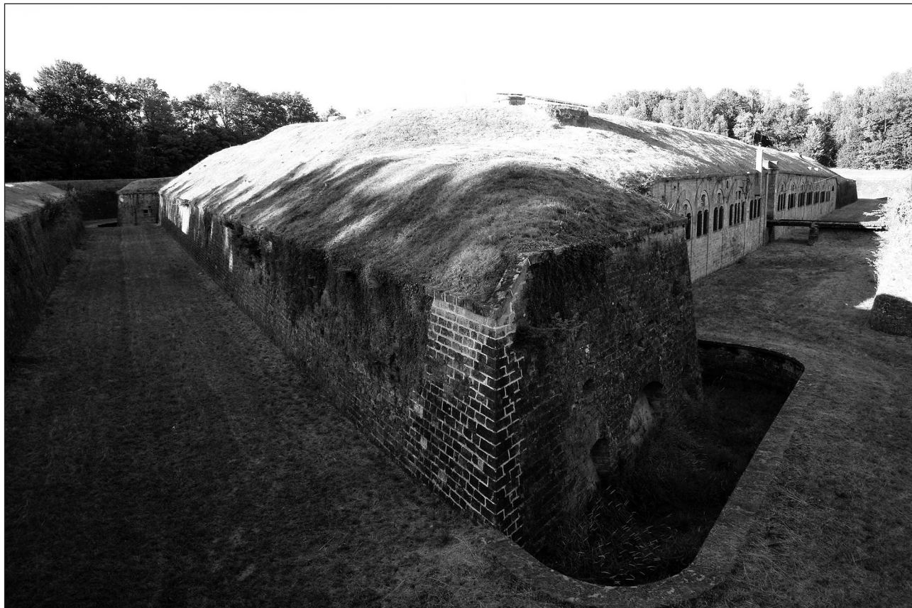
Илл. 12. Форт Буа л'Аббе (Bois L'Abbé). Форт избежал существенных модернизаций и в общем сохранил тот вид, который приобрёл при постройке в 1883–1885 гг. На переднем плане виден полукапонир, защищавший ров с горжевой стороны; слева вдали — капонир для обороны двух напольных участков рва. Справа вдали — вход мирного времени. Фотография автора, 2015 г.
