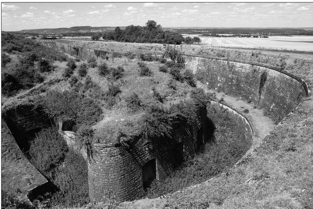
Илл. 13. Капонир Северной батареи форта Вилле-ле-Сек (Villey-le-Sec). У капонира устроен дополнительный ровик внутри главного рва. Фотография автора, 2015 г.
