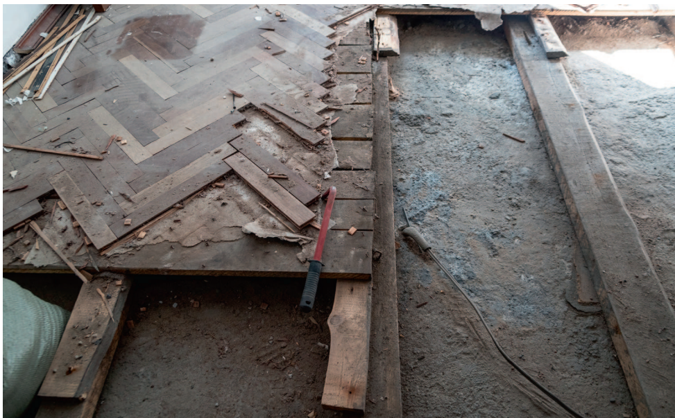
Снятие старого паркета в квартире, предназначенной для ремонта
