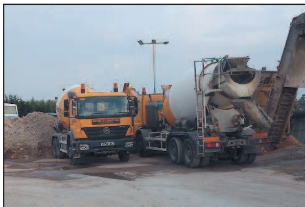
Рис. 13 Автомобили, доставляющие готовую бетонную смесь.
