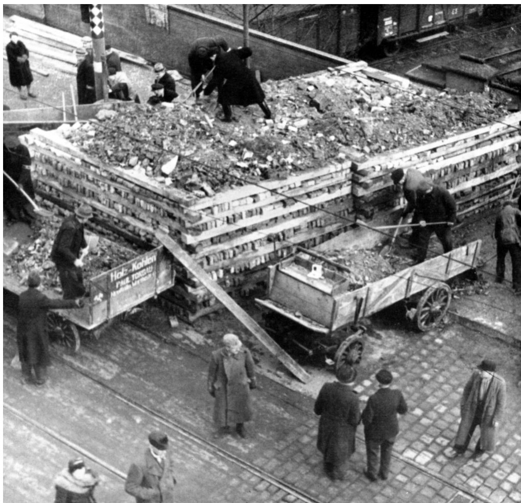
Строительство типичной для Германии баррикады поперек улицы. Стенки такого сооружения образовывали деревянные брусья или рельсы, а заполнялось оно камнями и землей. Подобные баррикады не преодолевались танками и выдерживали попадание снарядов до 152-мм калибра.
