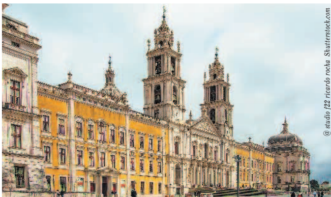
Дворец Мафра построен королем Жуаном V в 1730 г. Королевский дворец занимает верхний этаж постройки с двумя башнями. Северная башня была дворцом короля, а Южная — дворцом королевы, их соединяет коридор длиной 232 м
