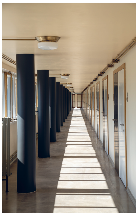
● Коридор дома Наркомфина, в котором видны несущие колонны, проходящие сквозь все здание
