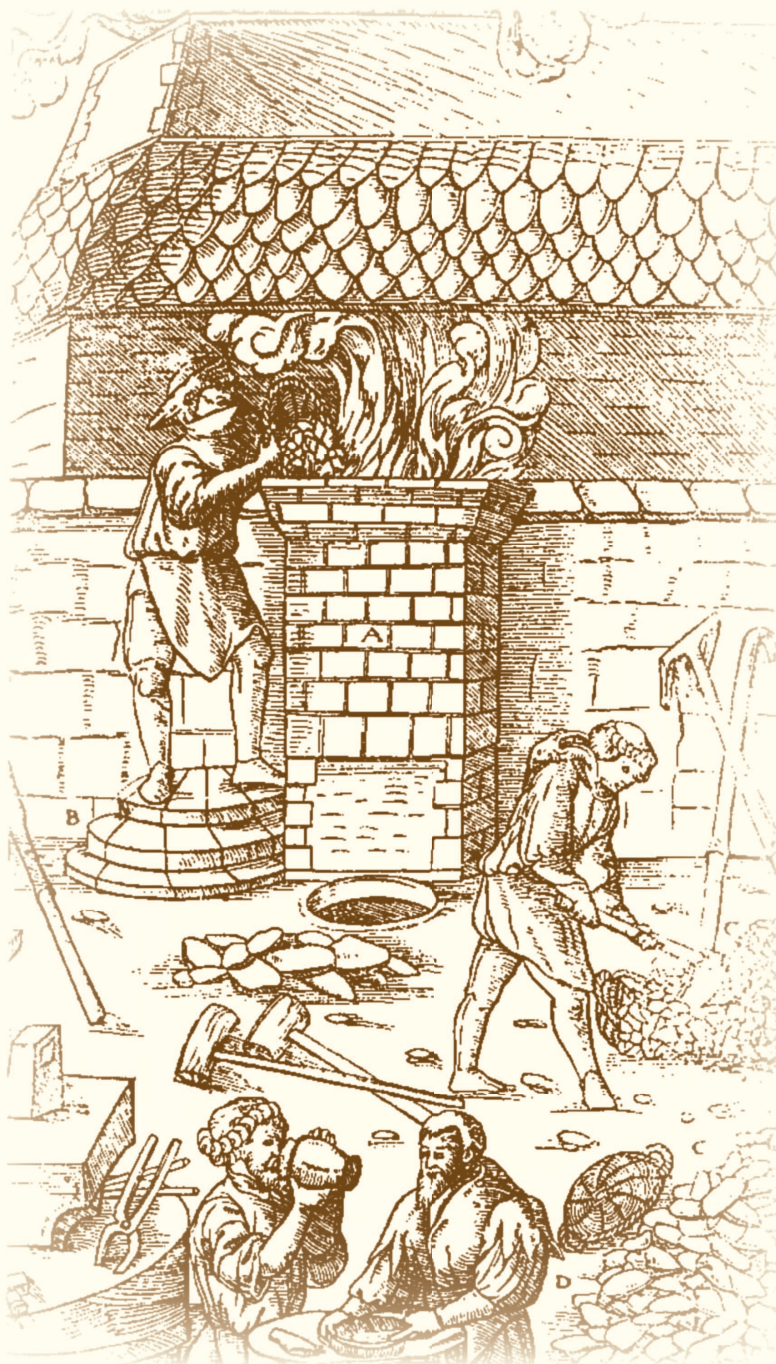
Закрытая шахта штукофена хорошо концентрировала тепло
