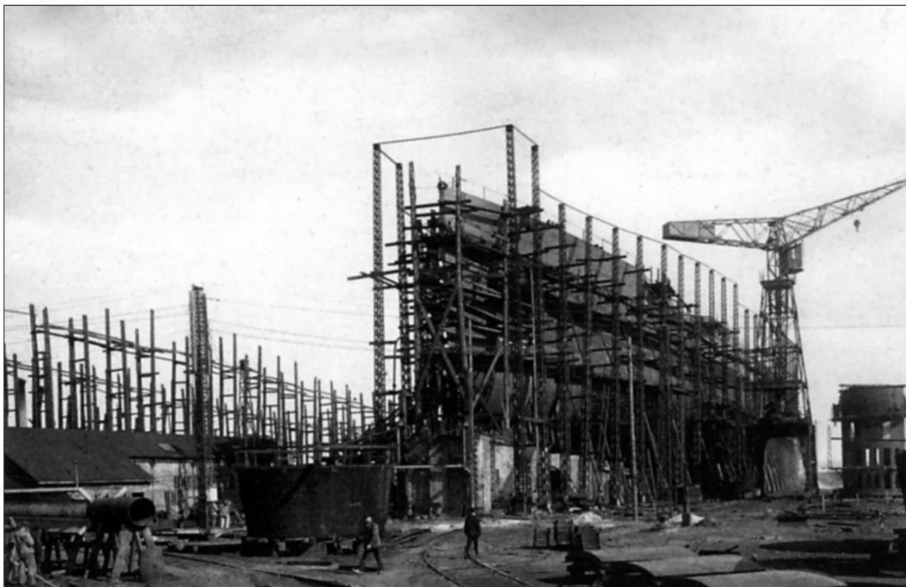
Броненосец «Кондорсе» на стапеле верфи «Ателье э Шантье де ла Луар» в Сен-Назере, начало 1909 г. Корпус уже собран до верхней палубы
