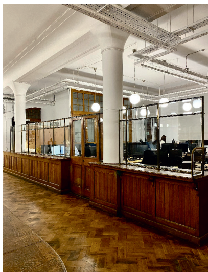
Чугунные колонны в корпусе бывшей фабрики «Эйнем»
