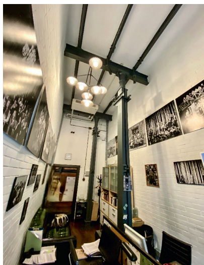
Чугунные опоры внутри Медеплавильного завода Товарищества «Алексеев, Вишняков, Шамшин»
