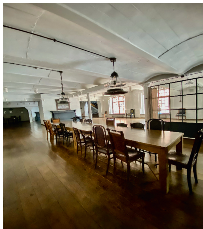
Железобетонные своды внутри Медеплавильного завода Товарищества «Алексеев, Вишняков, Шамшин»
