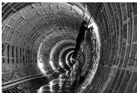
▲ Строительство московского метро продолжается и сейчас
