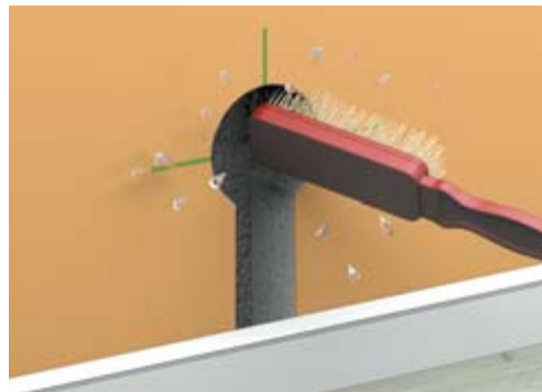
Рис. 7.8. Шаг шестой: перед тем как крепить коробку в отверстие, необходимо промыть его от пыли водой и нанести грунтовку
