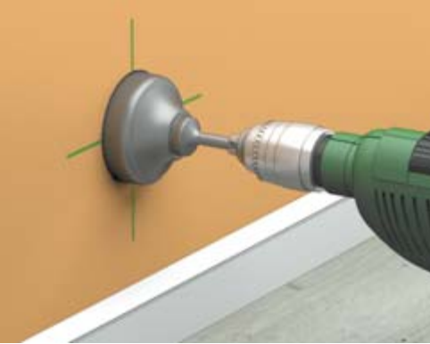
Рис. 7.3. Шаг первый: резка отверстия под электрическую точку — при помощи коронки по бетону в стене прорезается отверстие, сверло приставляется к центру пересечения линий
