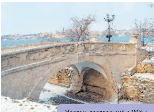
Мостик, построенный в 1905 г.
