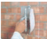
1. Толстой наносит на стену толстые клеевые подушки
