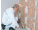
3. Еще одну полосу наносит на уровне плинтуса
