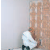
2. На уровне потолка наносит вспенившуюся полосу клея
