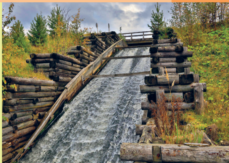
Деревянный водоброс Нючпасского водохранилища (XVIII–XIX вв.) на реке Нючпас в поселке Нючпас Койгородского района Республики Коми
