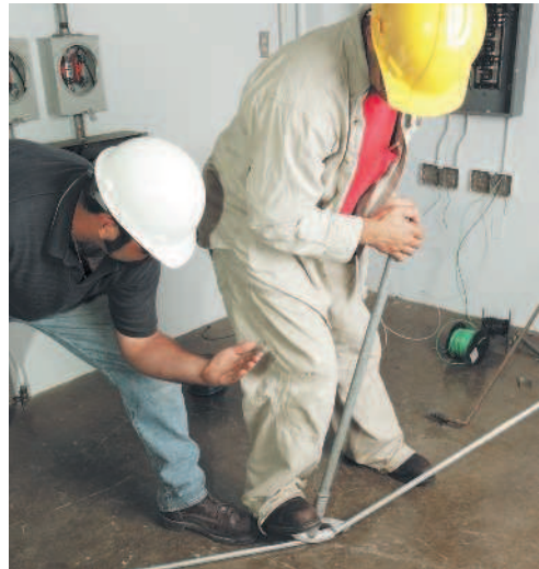
Рис. 1.11. Гибка трубы с помощью трубогиба
