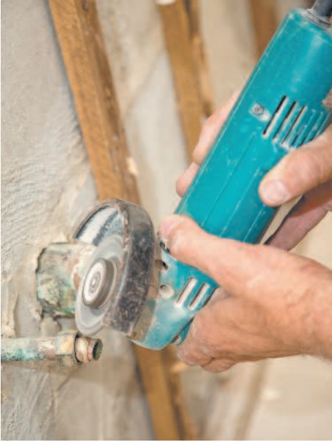
Рис. 1.15. Резка трубы с помощью болгарки
