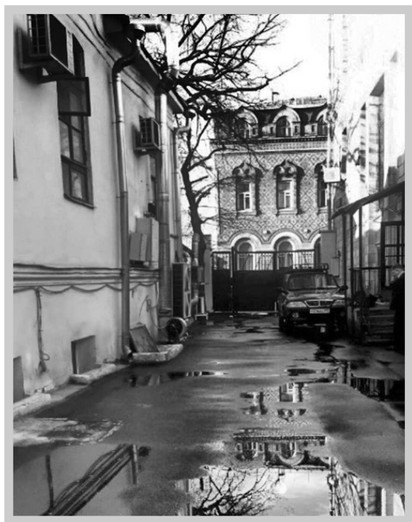
Окна нашего подвала — на уровне лужи
