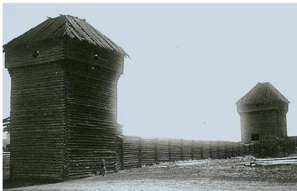
Якутский острог. Типичные стены и башни русских деревянных крепостей конца XVII - начала XVIII в.
