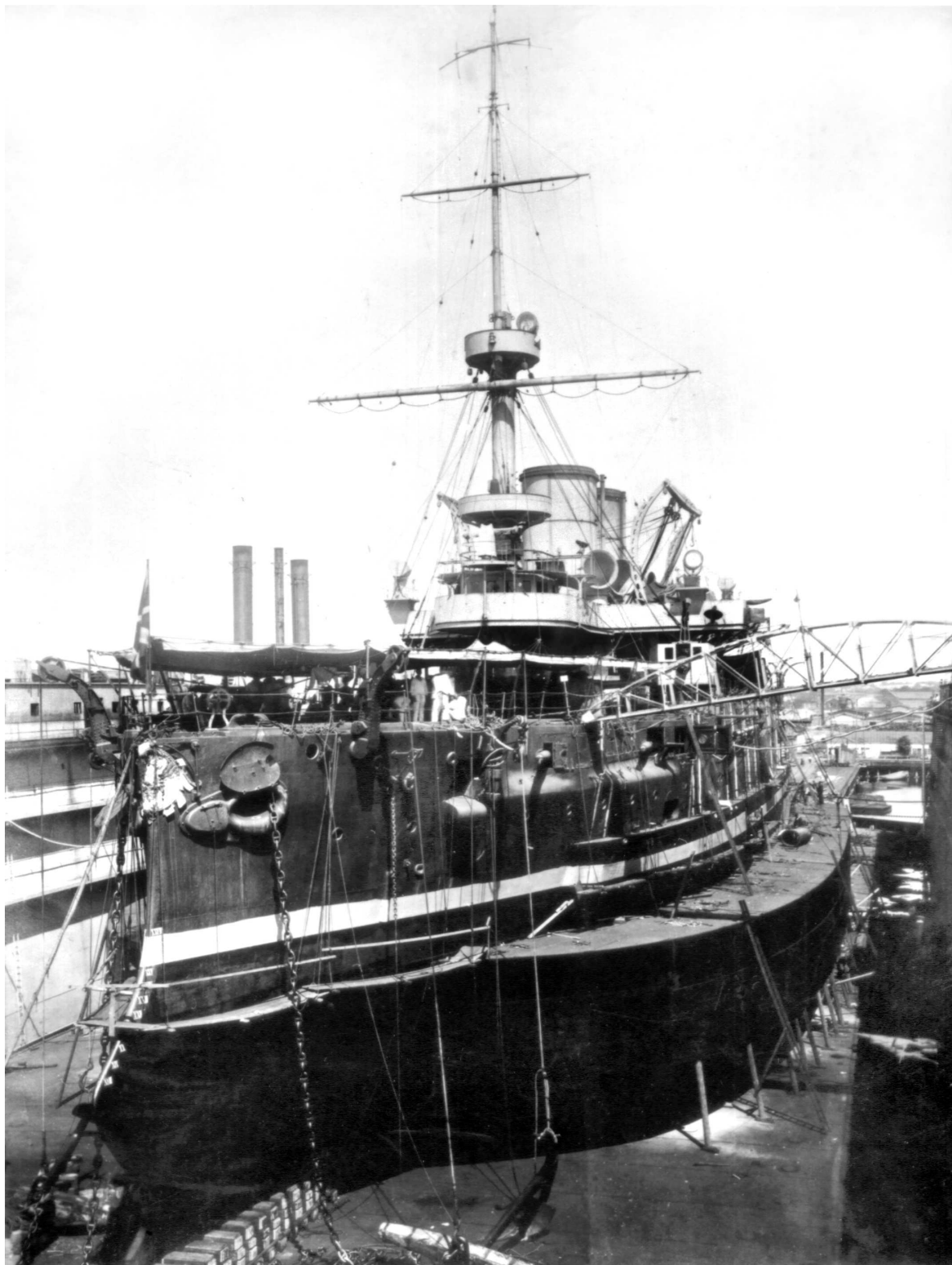
На линейном корабле (бывшем эскадренном броненосце) «Синоп» в 1916 г. были установлены противоминные кессоны (фото предоставил А.Н. Одайник, Украина).
