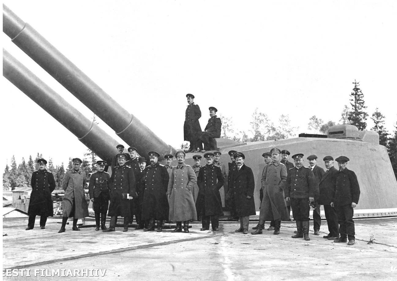
Двухорудийная 12-дм/52 башенная установка сухопутного ведомства на о. Нарген. 1916 г. (фото предоставил М. Трутс, Эстония).
