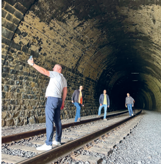
■ В одном из тоннелей КБЖД
