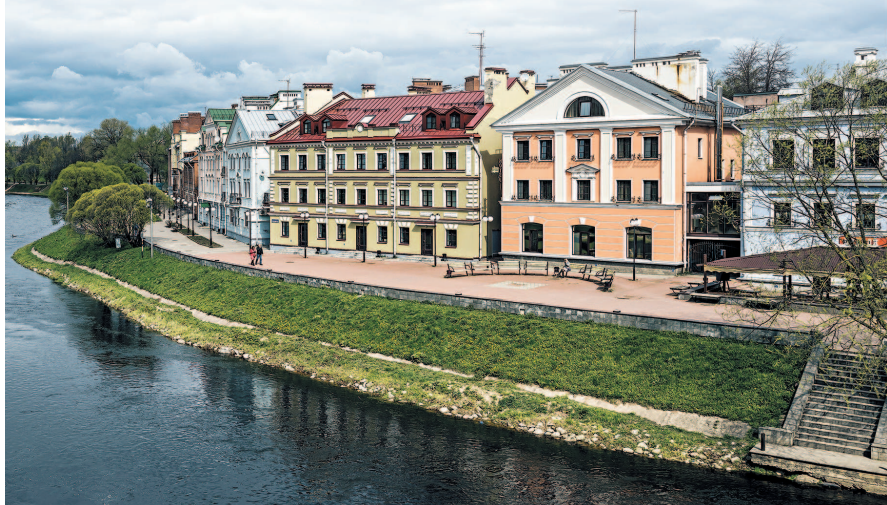
Золотая Набережная, жилой район в историческом месте Пскова.
