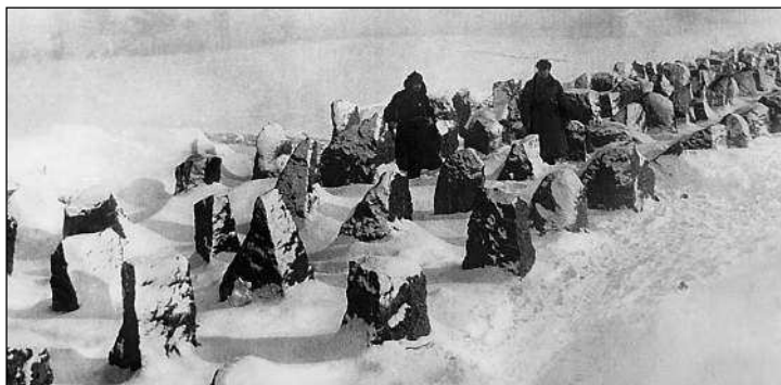
Красноармейцы на линии гранитных противотанковых надолб – размер последних можно оценить, сравнив их с фигурками людей (АСКМ).
