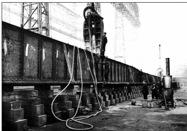
Два снимка сверху: сборка вертикального киля «Олимпика»
