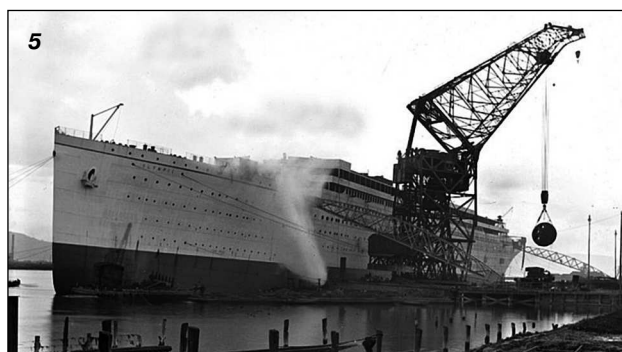
1 и 2 – спуск «Олимпика» на воду; 3 и 4 – «Олимпик» после спуска. Дымовые трубы на снимке 4 появились трудами ретушера; 5 и 6 – погрузка паровых котлов на «Олимпик»
