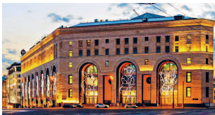
После реконструкции на крыше Центрального детского магазина открыта смотровая площадка, с которой открываются виды на исторический центр Москвы.
