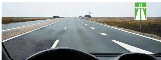
На картинке вариант автомагистрали с тремя полосами движения в одном направлении, разделенная разметкой 1.16.3 и обозначена знаком 5.1
