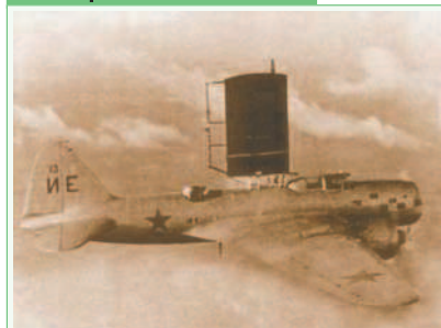
Сооружение над фюзеляжем ДБ-3ЛЛ — модель отсека крыла, установленная для изучения характера обтекания нового профиля воздушным потоком в условиях реального полета.
