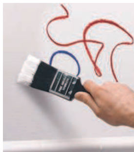
Замажьте граффити грунтовкой для пятен
