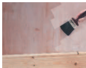
Новую штукатурку покройте щелочестойкой грунтовкой
