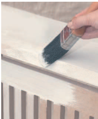
МДФ обработайте специальной грунтовкой
