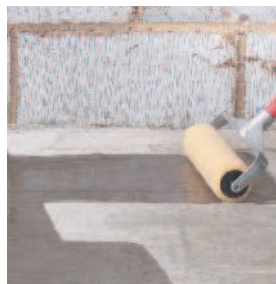
Пористый бетон обработайте герметизирующим составом
